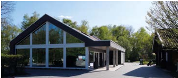
Neues Verwaltungsgebäude mit integriertem Pro Shop beim Club am Meer
