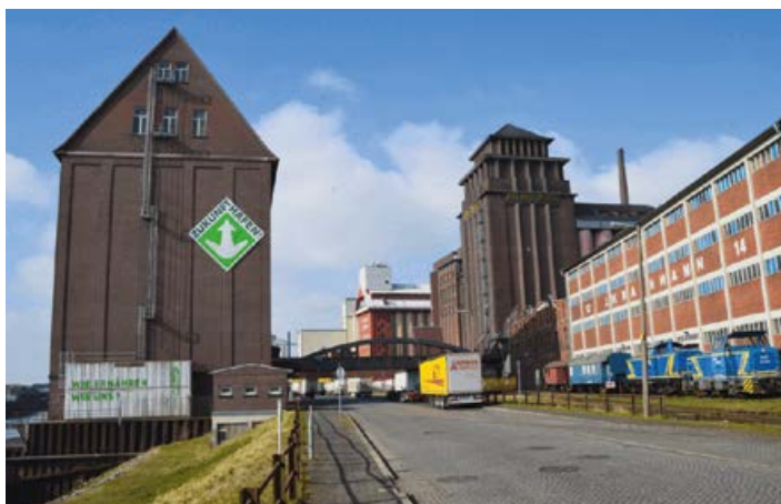
1897 wurde die Rolandmühle im Getreidehafen erbaut. Seitdem werden hier verschiedenen Getreidearten gemahlen.
