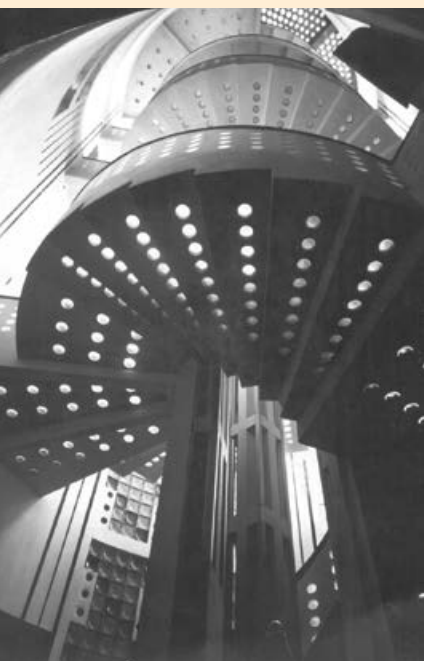
Treppe im Haus Atlantis vor 1944.
